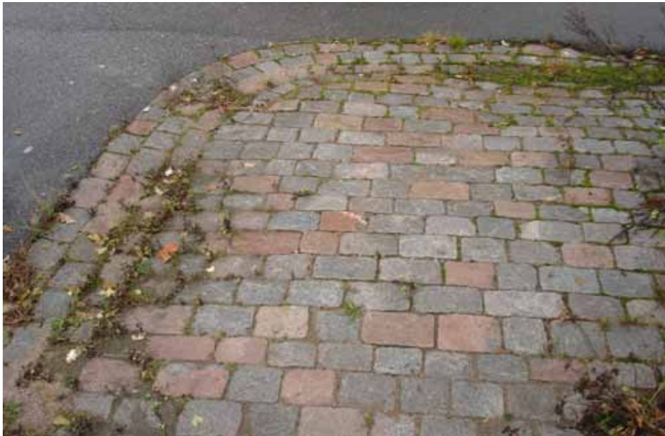
Bild 15. Detalj markbeläggning med storgatsten vid grenadjärregementet.
