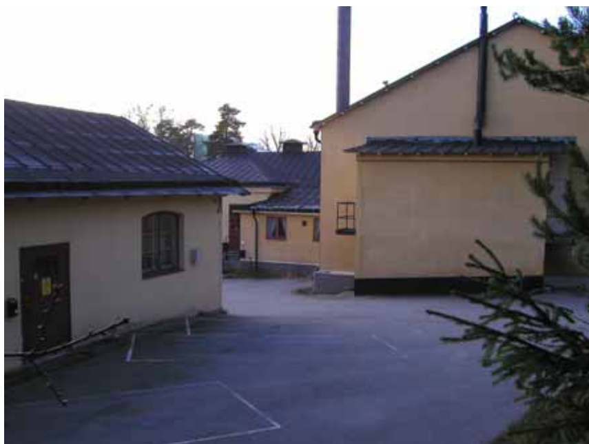
Byggnad 167 t.v. och 105 t.h.
